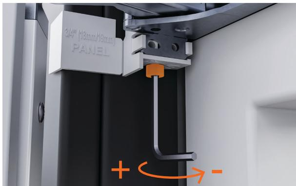
5. Ouvrir la porte et utiliser la clé Allen fournie pour déployer la cale d'espacement supérieure afin de créer un espace uniforme entre le produit et l'alcôve.
