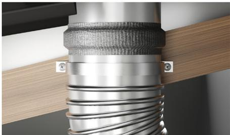
Si nécessaire, sécurisez le conduit dans le plafond.
