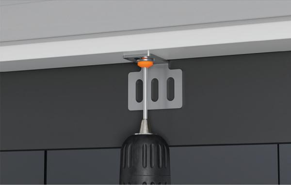
1. Lösen Sie bei geöffneter Tür die untere Halterungsschraube. Passen Sie die Halterung so an, dass sie an der Türblende anliegt. Ziehen Sie die Schraube der Halterung wieder fest.
